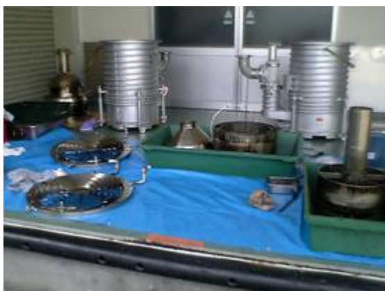
拡散ポンプのメンテナンス作業
